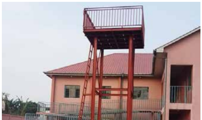
Bouw van de < constructie van de waterciternes
