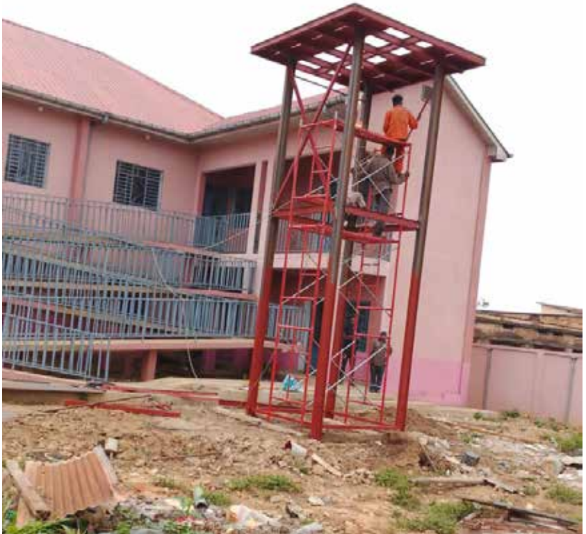
Bouw van de constructie van de waterciternes ^
